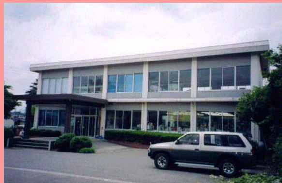
【土地改良区事務所の新增築に】
